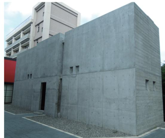
写真-1: CfFA コンクリートを用いた実物大の RC 造住宅模型
