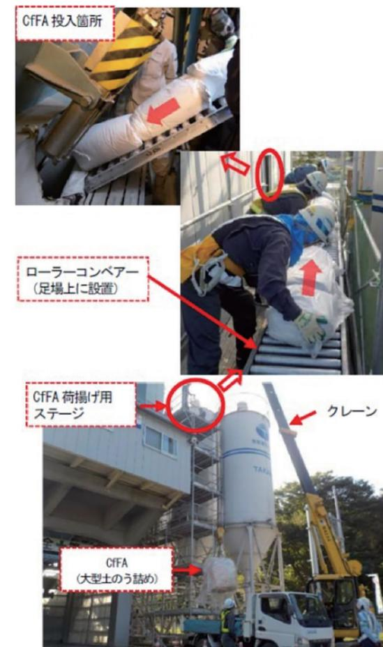
写真-1: CfFA 投入設備
