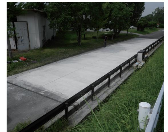
写真-2: CfFA コンクリートを用いたコンクリート舗装
