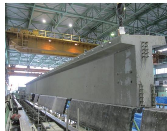
写真-1: CfFA プレキャスト PC 桁の製作状況
