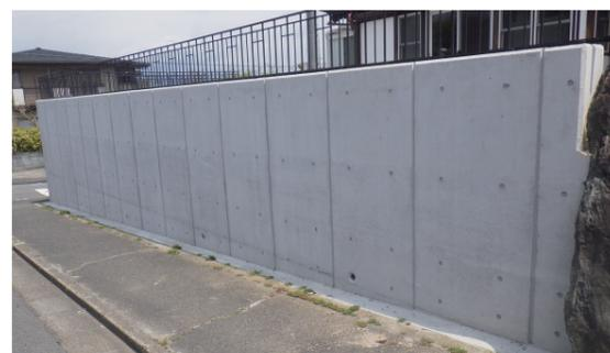
写真-2: 土庫擁壁 27-18-20N(CfFA 内割換算 30%配合)
