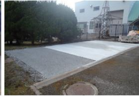
1day pave 舗装用コンクリート試験施工(秋田大学コンクリート工学実験室)
